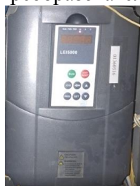
Рисунок 4. – Частотный преобразователь 5,5 кВт с LEI5000-5R5-PB-3
